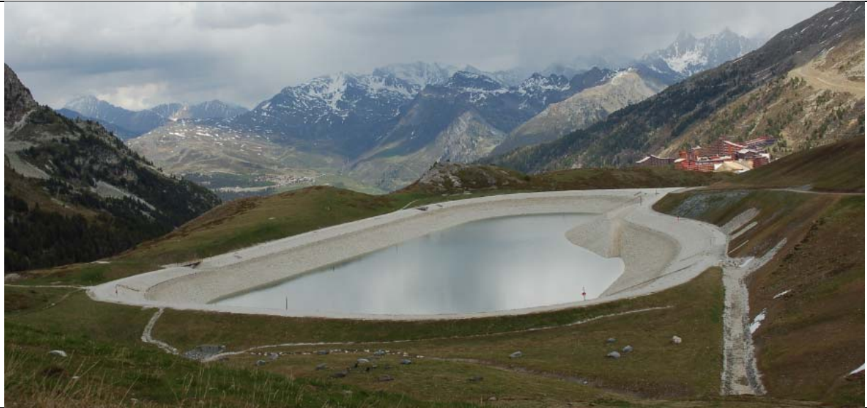
Abbildung: Speicherteich des Skigebiet „Les Arcs“ mit 500.000m 3 Fassungsvermögen
