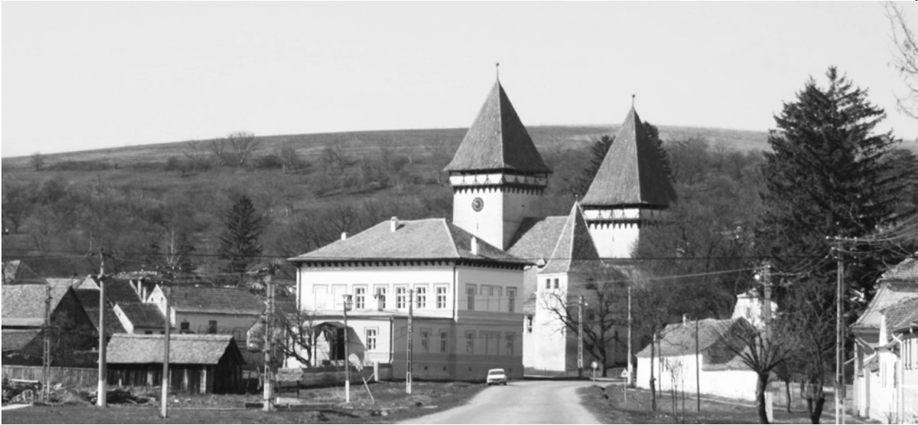
Fig. 4. Dealu Frumos/Schönberg Summer Campus of "Ion Mincu" University of Architecture and Urbanism, Bucharest. Source: M. Breiling, July 4th, 2018. Campusul de vară al Universității de Arhitectură și Urbanism "Ion Mincu", București. „, Sursa: M. Breiling, 4 iulie, 2018.
