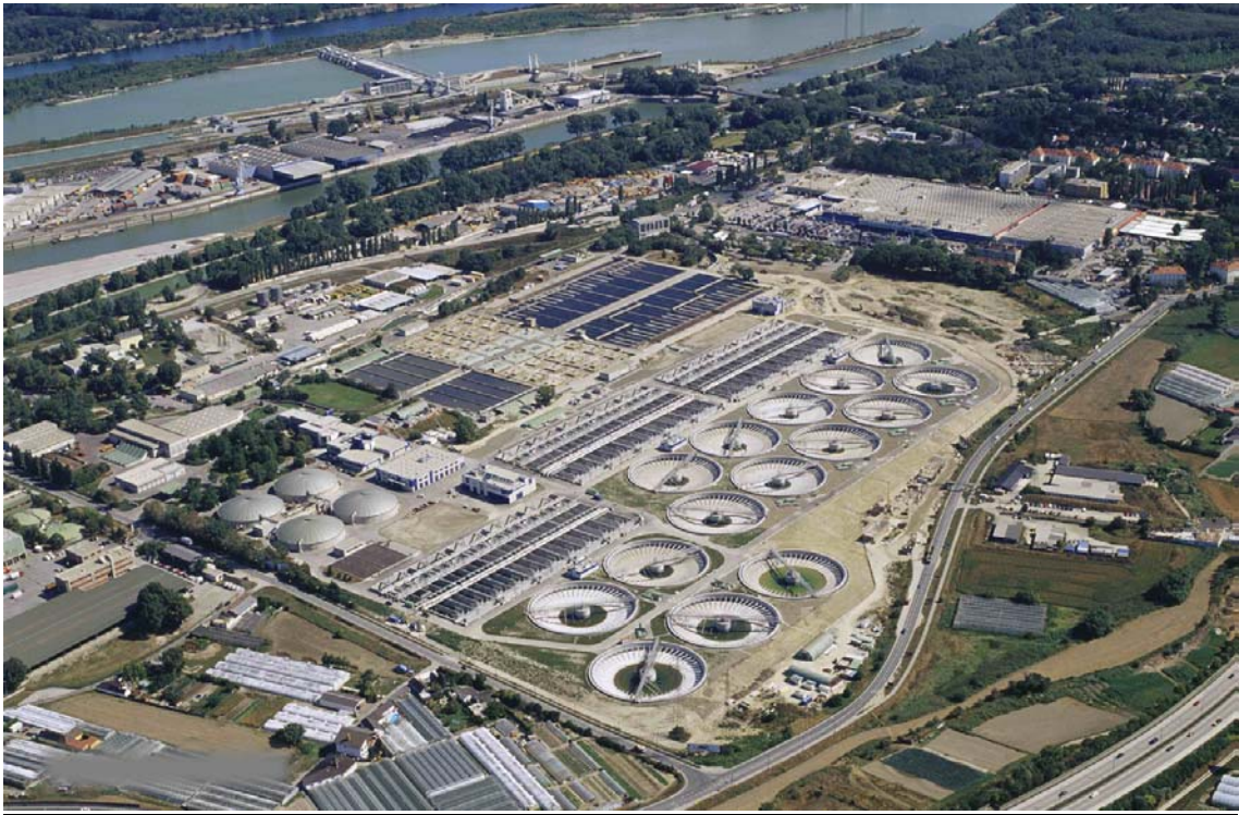
Abb.7 Luftaufnahme Hauptkläranlage Herbst 2004
